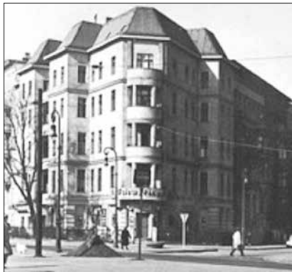
Kriegsschäden: Türmchen und Stuck sind weg
