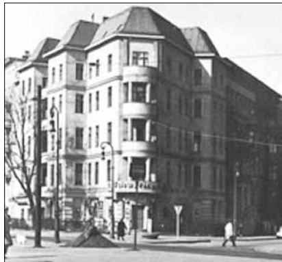
Kriegsschäden: Türmchen und Stuck sind weg
